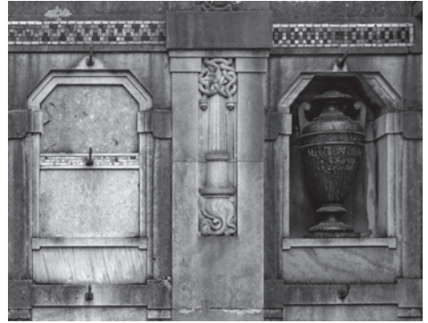
Teil einer Urnengrabanlage auf dem Engesohder Friedhof
